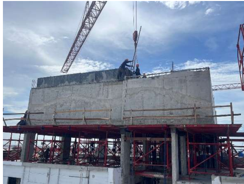
งานรื้อแบบผนังแท่งน้ำ ชั้น ดาดฟ้า อาคาร B1
