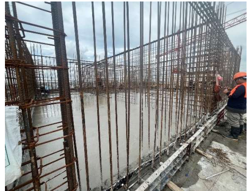
งานเทคอนกรีตพื้นแทงค์น้ำ ชั้น ดาดฟ้า อาคาร B2
