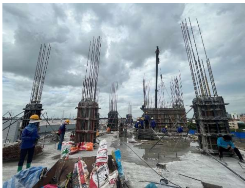
งานเทคอนกรีตเสา,ผนังลิฟต์ ชั้น 5 อาคาร C2
