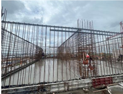
งานเทคอนกรีตพื้นแทงค์น้ำ ชั้น ดาดฟ้า อาคาร B2
