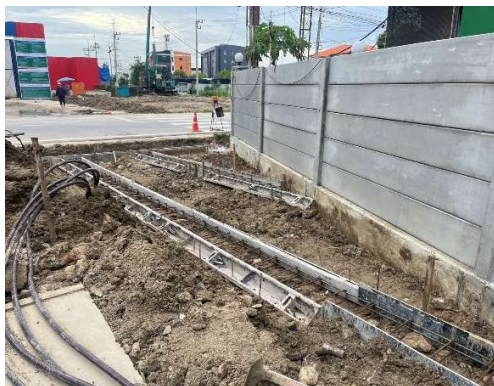
งานเทลิ้นกระบะปลุกต้นไม้ อาคาร D
