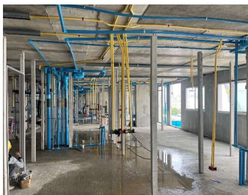
งานเดินท่อไฟฟ้า ชั้น 5 อาคาร B2
